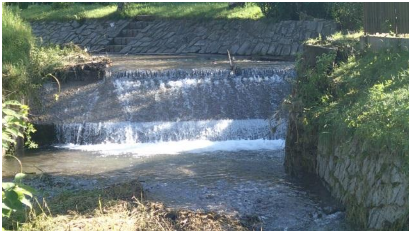
Pohled na betonový stupeň
